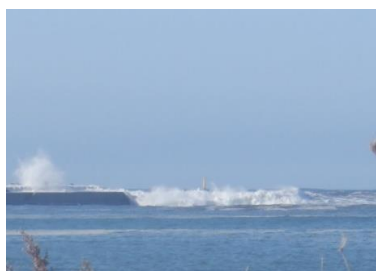
防波堤の越波状況
