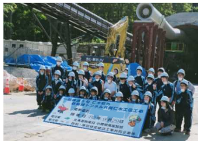
国道工事現場における教育旅行の受入れ
