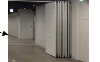
通路等の遮蔽設備
