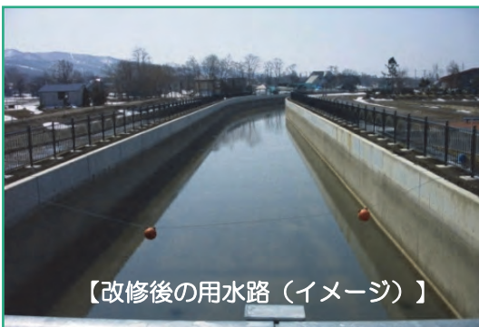
【用水路の改修状況】
