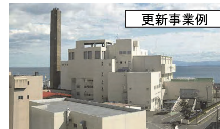
更新事業例 函館市 清掃工場（機器更新工事） (R9年度完成予定) 写真提供：函館市
