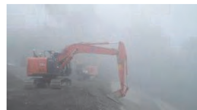
濃霧条件下での施工状況
