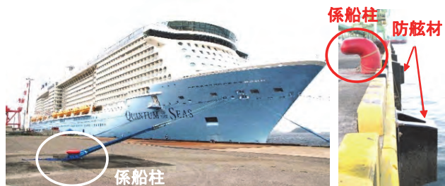
大型クルーズ船の係留に対応した係船柱※1・防舷材※2の設置。
