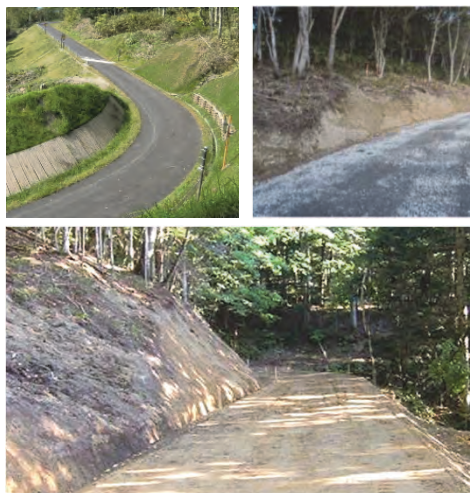
(左) 幹線となり一般車両の走行も想定した「林道」、(右) 10t積み程度のトラックの走行を想定した「林業専用道」、(下) 林業機械の走行を想定した「森林作業道」
