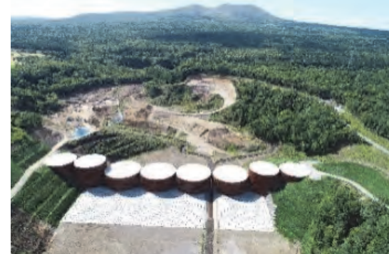
おぼっぶ 樽前山覚生川2号砂防堰堤（苫小牧市）
