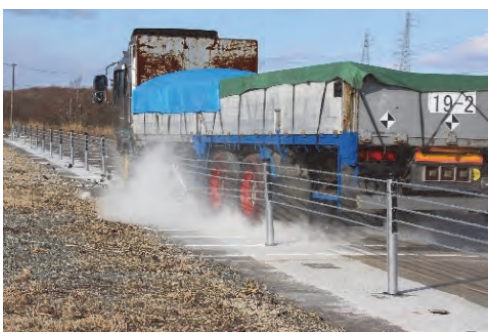
ワイヤロープ式防護柵の衝突実験 (共同研究)
