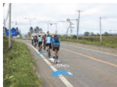
路面への通行位置明示
