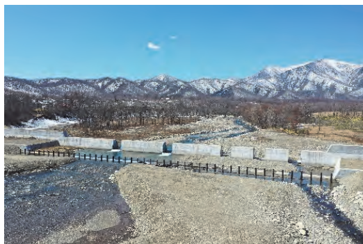
とったべつ 十勝川水系戸蔦別川第2号砂防堰堤（帯広市）
