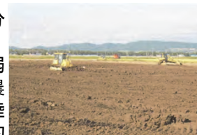
整地工の状況
