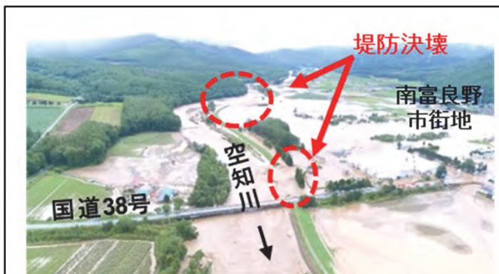
空知川の被災状況
