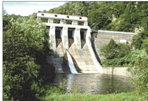
雨竜川ダム再生事業（雨竜第二ダム（幌加内町）） （堤体かさ上げ・容量振替予定）
