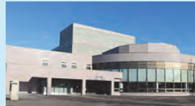
防災設備の改修（中標津町）
