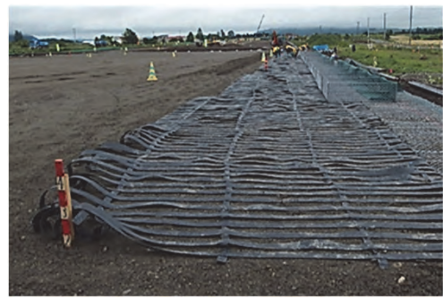
軟弱地盤上の盛土を補強するための グラベル基礎補強工法の施工
