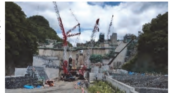
工事中の平取ダム（平取町）
