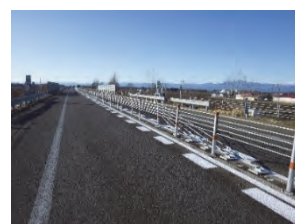
高規格幹線道路の暫定2車線区間におけるワイヤロープの設置
