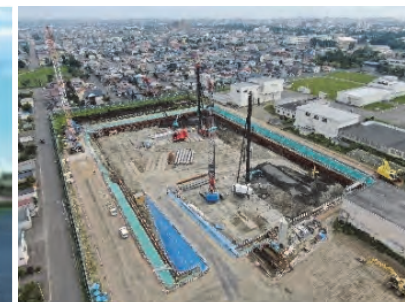
新浄水場施工状況 写真提供：釧路市
