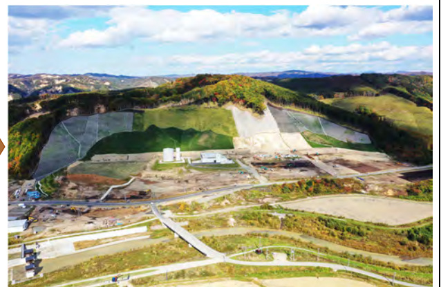
令和2年7月に浄水場からの給水が再開し、再度災害防止のための法面工事進む
