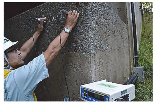
非破壊試験(表面走査法)による 凍害点検の様子
