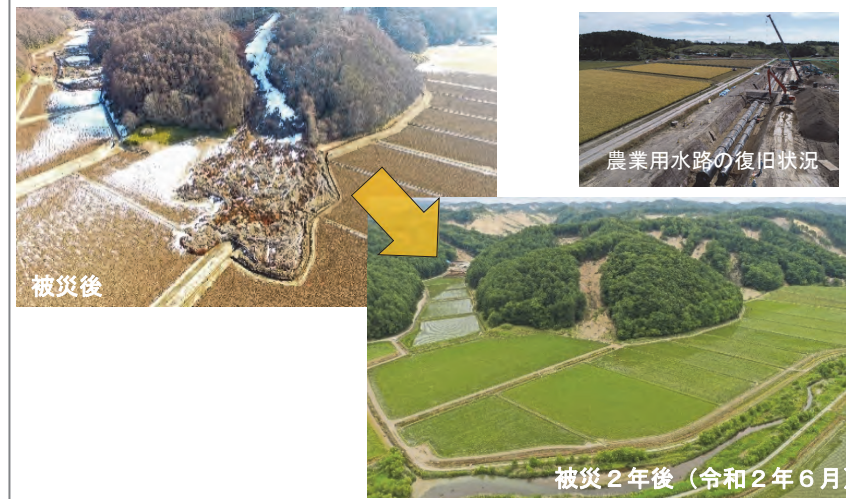
農地・農業水利施設の復旧状況
