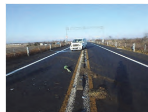
【正面衝突事故対策:ワイヤロープの設置】
