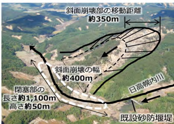
日高幌内川では、山腹崩壊の発生により大規模な河道閉塞が発生
