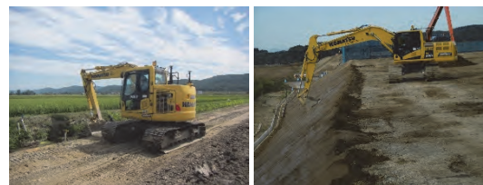
道路の新設工事における実施事例(千歳市)
