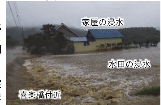
喜楽橋付近 ペーバン川（旭川市）の浸水被害状況 （平成30年7月）
