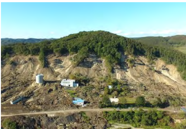
厚真町富里地区では、斜面崩壊により浄水場施設等への被害が発生
