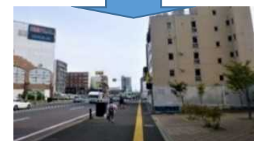
整備後(撮影 令和元年度)
