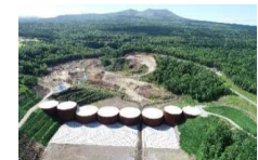
樽前山覚生川2号砂防堰堤(苫小牧市)
