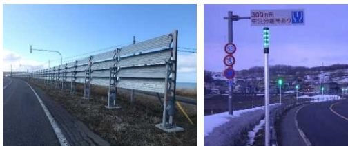
防雪柵の整備
