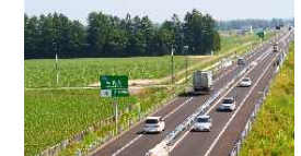
帯広広尾自動車道
