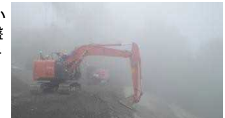
濃霧条件下での施工状況
