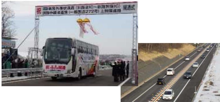
釧路外環状道路(釧路東IC～釧路別保IC) 釧路中標津道路(一般国道272号)上別保道路開通 (平成31年3月)
