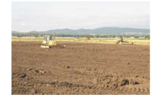
整地工の状況
