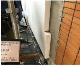
断熱材貼り付け
