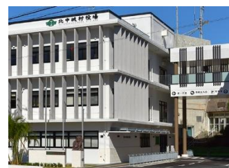
建物周りのバルコニーとルーバー
