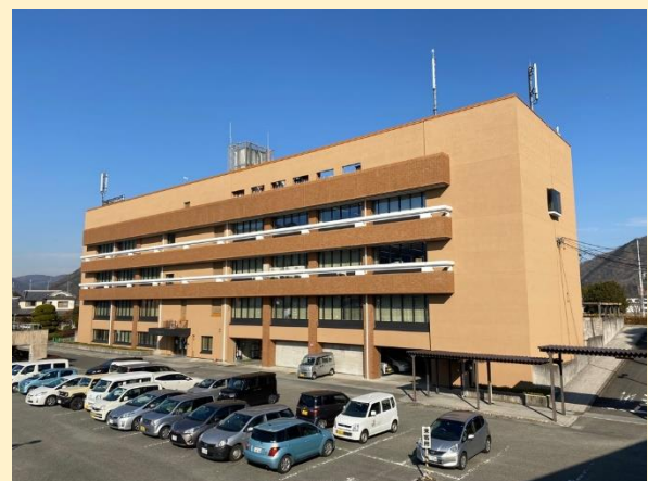
改修後の庁舎外観
