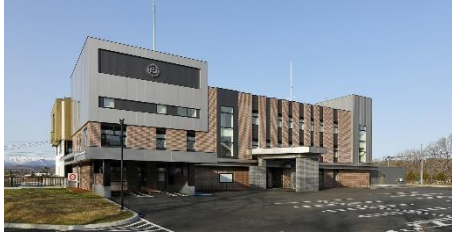
外壁の外観(庁舎)
