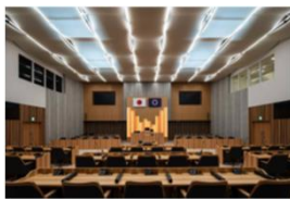
議場の膜天井
