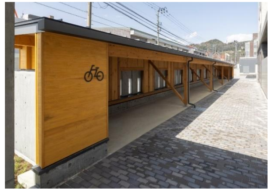
福島第2地方合同庁舎(福島県福島市) 自転車置場(木造化)
