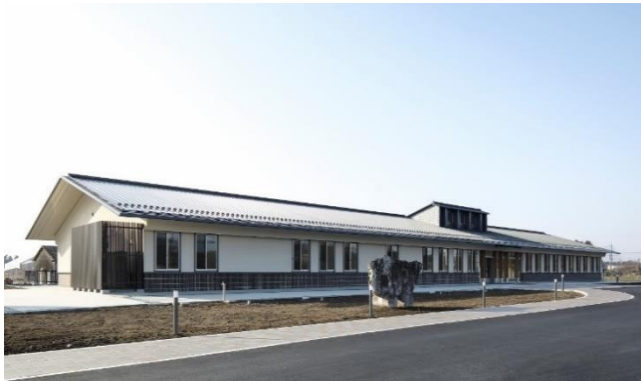
農林水産研修所つくば館水戸ほ場(茨城県水戸市) 研究本館(木造化)
