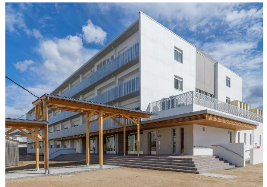
中国四国管区警察学校生徒寮(広島県広島市) 渡り廊下(木造化)
