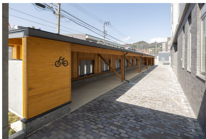
<福島第二地方合同庁舎（自転車置場）>
