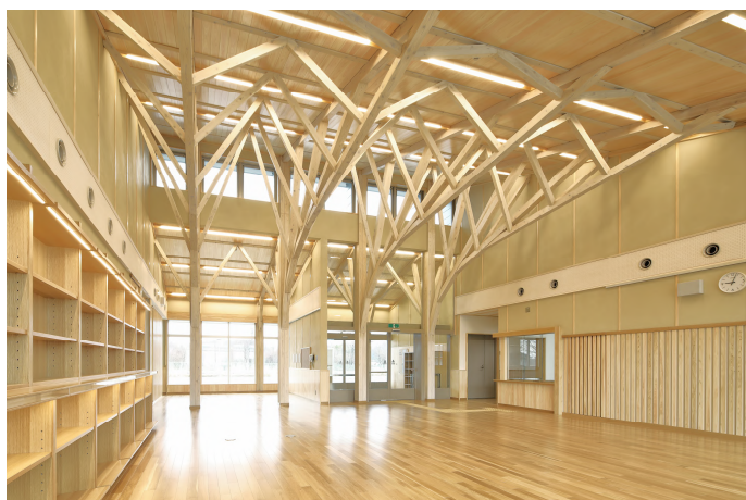
<農林水産研修所つくば館水戸ほ場 研修本館>
