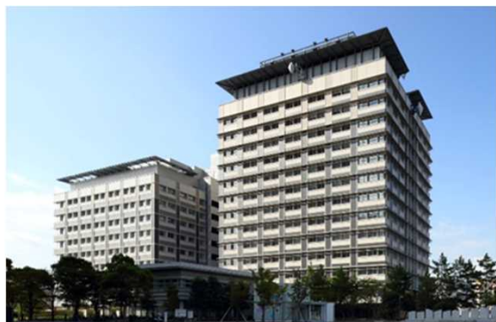
(高松サポート合同庁舎)
