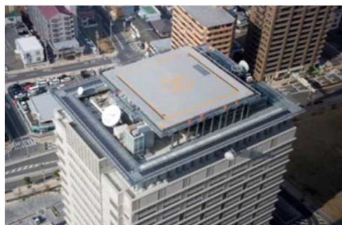
屋上ヘリポート
