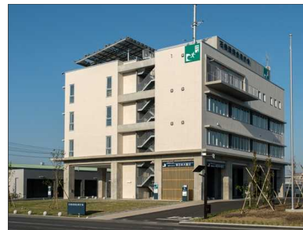
津波対策を実施した庁舎の例 (石巻港湾合同庁舎)
