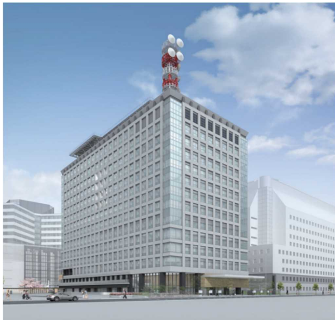
大阪第6地方合同庁舎（仮称）
