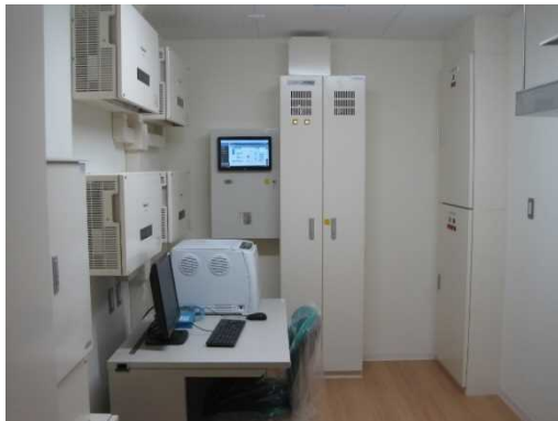
2階サーバー室（BEMS、太陽光パワコン）
