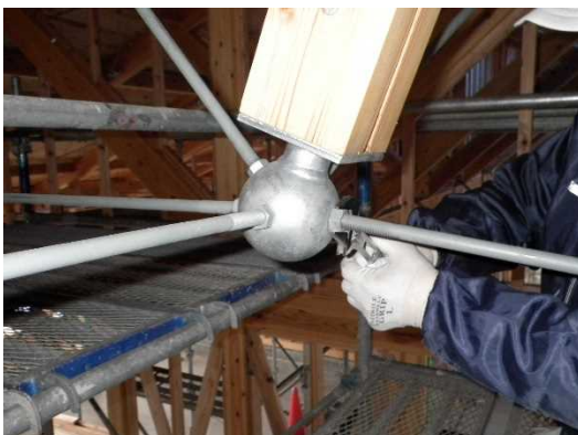
写真4 張弦トラスと柱の接合金物
