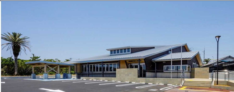
南紀熊野ジオパークセンター外観
