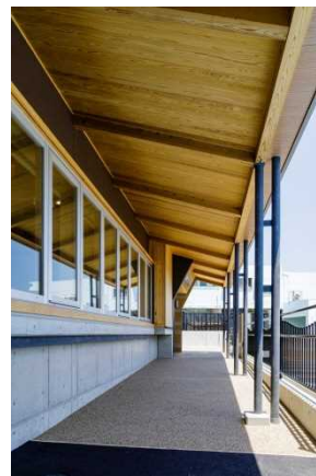
正面軒下アプローチ
