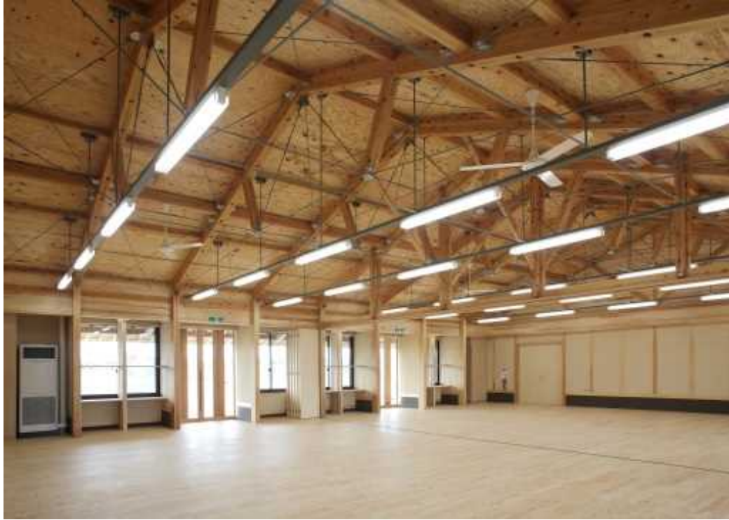
写真6 セミナールーム（張弦トラス完了状況）
