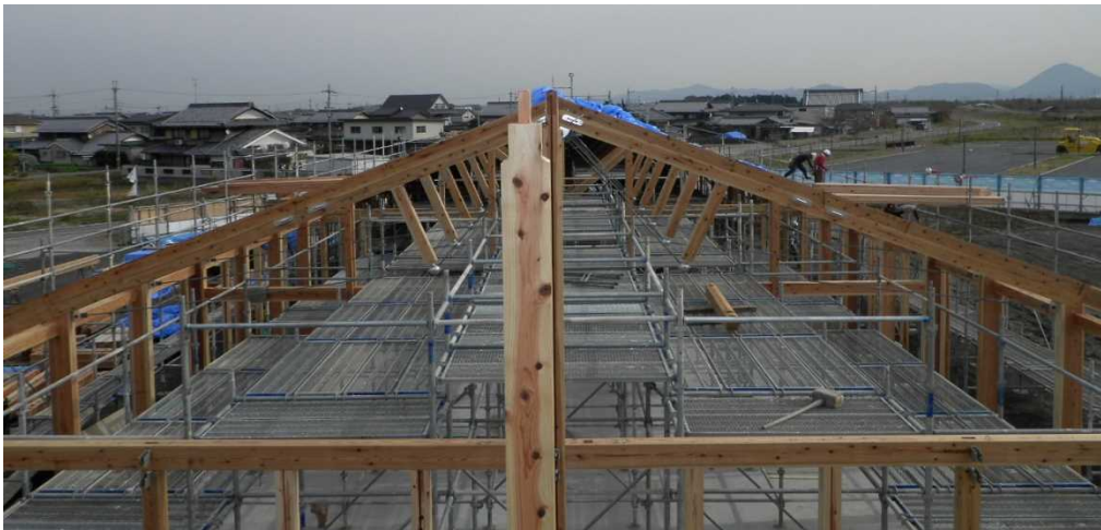
写真3 建て方時 張弦トラス設置状況
