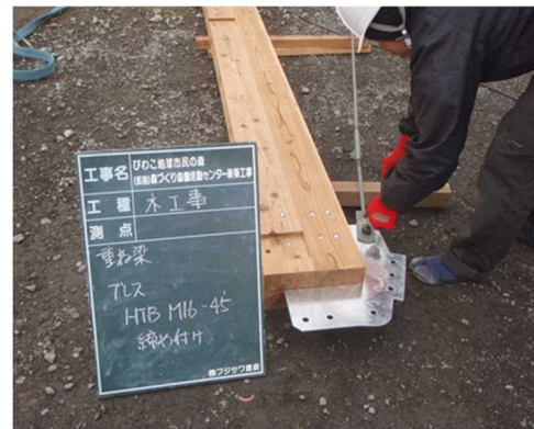
写真2 重ね梁と張弦材接合部
