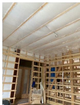
天井の改修風景
