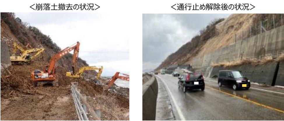
・復旧作業では掘削用重機最大8台を投入、延べ3,600台のダンプトラック（10t）が稼働し、約14,000m<sup>3</sup>の土砂とコンクリート殻を搬出
