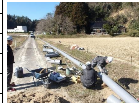
珠洲市:熊谷汚水中継ポンプ場から珠洲市浄化センターまでの仮設圧送管の布設
