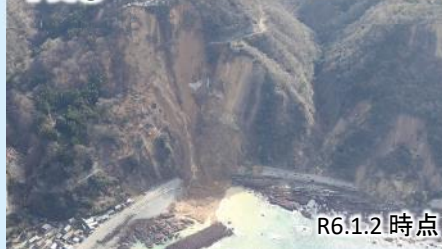
写真③ 国道249号法面崩落
