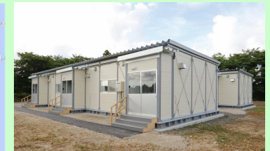
プレハブ住宅（設置例）
