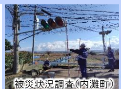
被災状況調査(内灘町)
