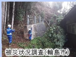
被災状況調査(輪島市)
