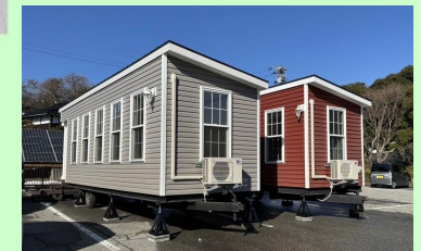
トレーラーハウス（設置例）
