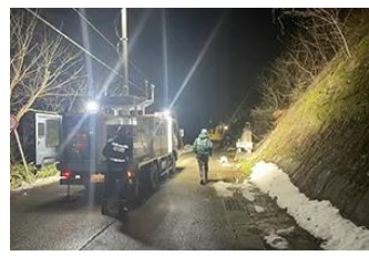
照明車 輪島市 夜間照明
