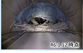
写真① 国道249号中屋トンネル
