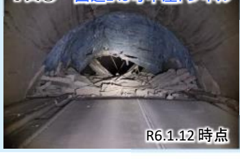
写真① 国道249号中屋トンネル
