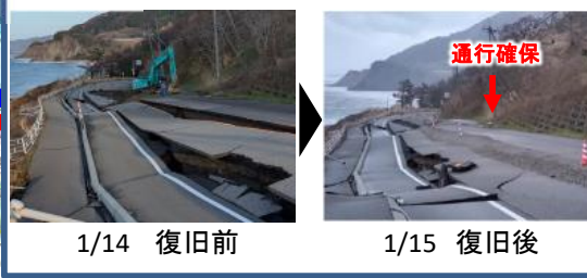
写真② 国道249号緊急復旧完了
