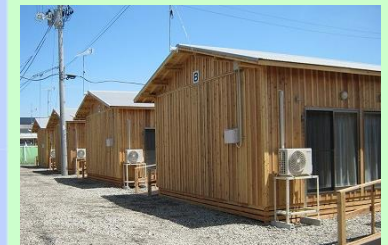
木造仮設住宅（設置例）
