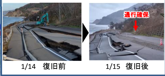
写真③ 国道249号緊急復旧完了
