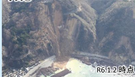
写真④ 国道249号法面崩落
