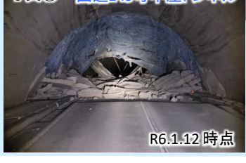
写真① 国道249号中屋トンネル
