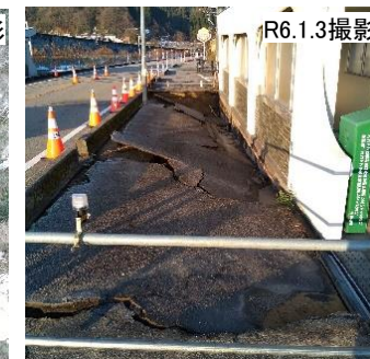
国道471号(小矢部市)
