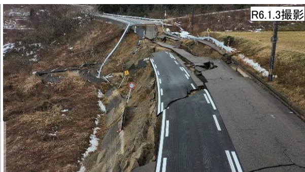
国道359号(小矢部市)
