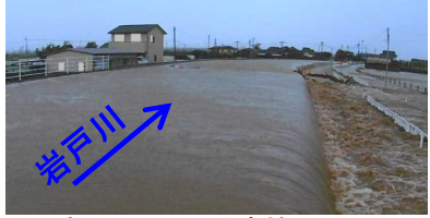
岩戸川の氾濫状況
