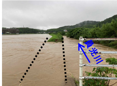
② 員光川の堤防決壊 (応急復旧完了)
