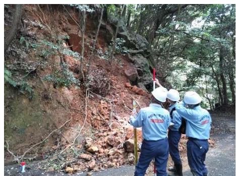
道路の被災状況調査(山口県美祢市)
