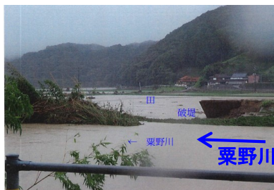
粟野川の堤防決壊（応急復旧中）
