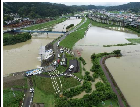
排水ポンプ車による排水活動(愛媛県大洲市)
