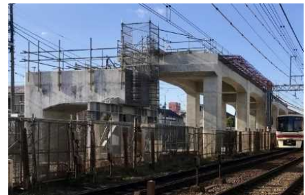
一部完成した高架橋躯体
