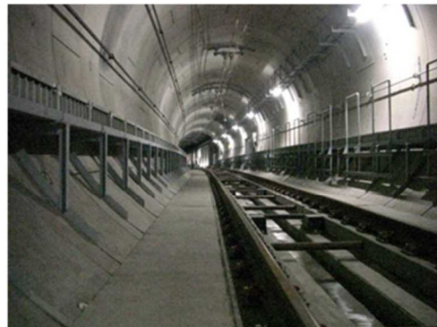
トンネル内照明のLED化
