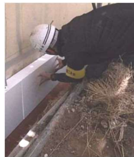
外壁の断熱化工事
