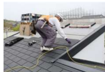
屋根の断熱化工事
