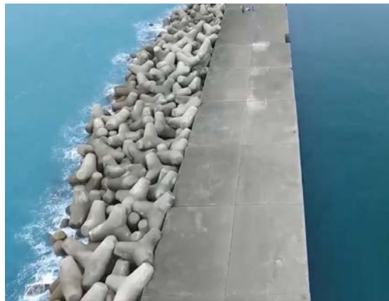
②本体工のずれ（変状なし）動画ファイル2：3分21秒頃
