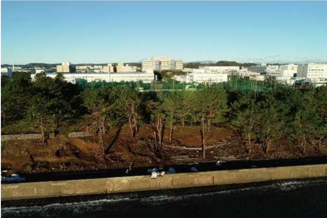
図-4 金沢区福浦地区 築山付近
