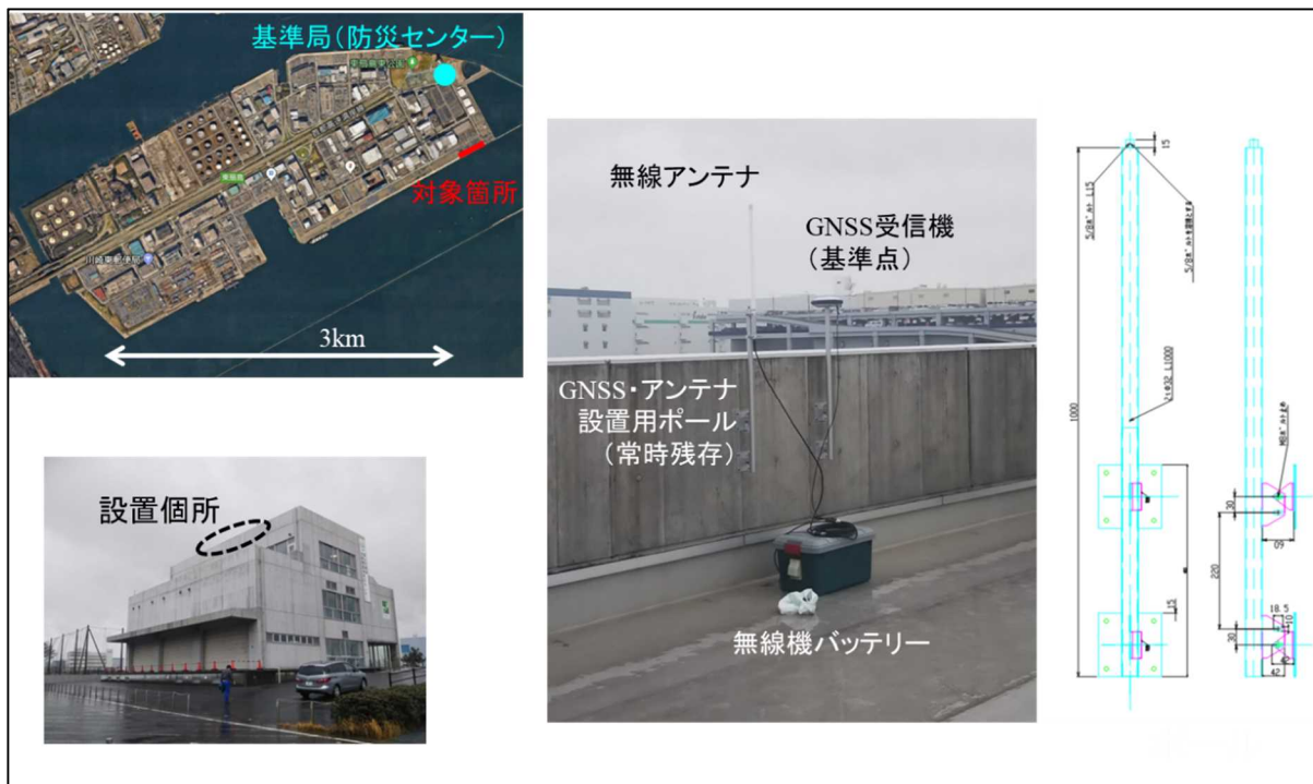
(事例) 関東地方整備局首都圏臨海防災センター屋上に基準点設置
