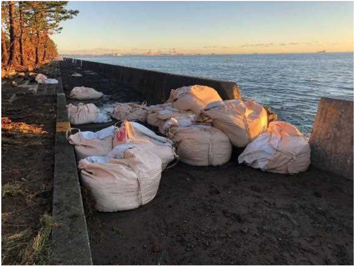
図－2 金沢区福浦地区土嚢の飛散状況
