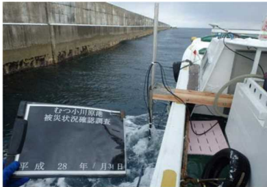
測量(データ測得)状況
