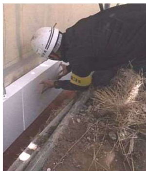
外壁の断熱化工事
