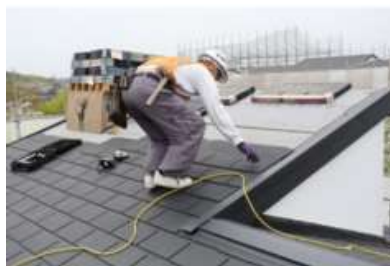
屋根の断熱化工事
