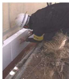
外壁の断熱化工事
