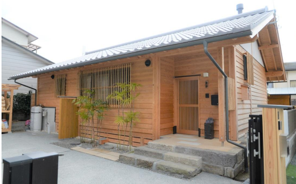
深い軒・格子・板張りの北側外観
