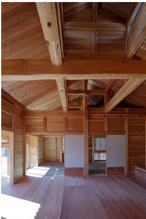
落とし込み板壁構法の開放的な空間
