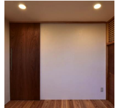
漆喰による塗壁
