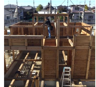
古材・リサイクル材の利用
