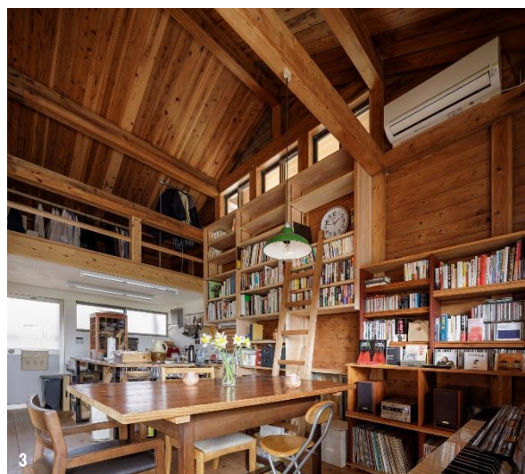
3 屋根裏空間を最大限利用した吹き抜けと新設した高窓
