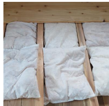
古材・リサイクル材の利用
