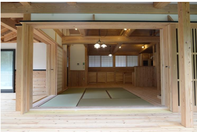
多層構成の木製建具を全面引き込むことができる大開口部
