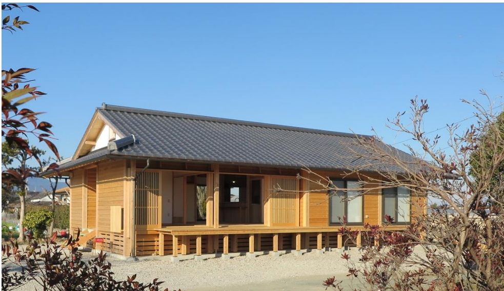
地域の景観と調和した入母屋屋根の外観
