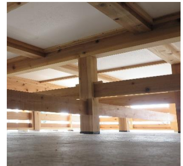
開放的な床下（石場建て）
