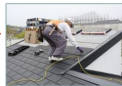
屋根の断熱化工事
