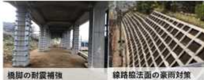
橋脚の耐震補強
