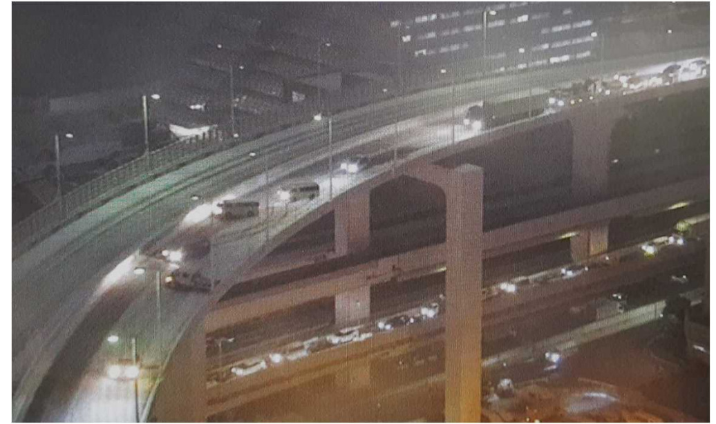
車両の滞留 ＜首都高速道路 台場線＞
