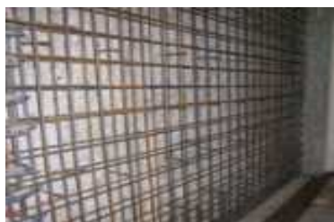
耐震壁増し打ち
