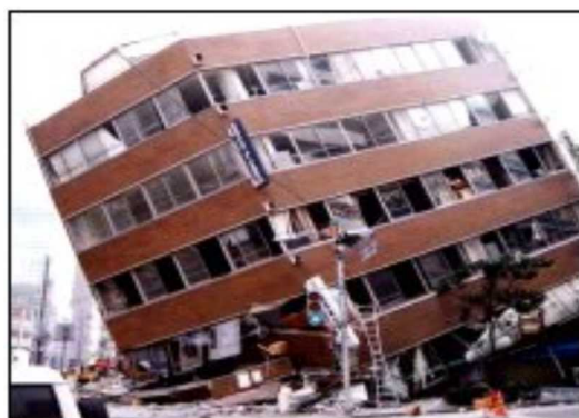
事務所ビル1, 2階の崩壊
