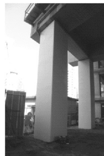
鋼板巻きによる高架橋の補強
