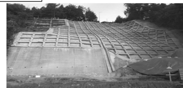
コンクリート枠による補強
