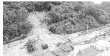
平成30年7月豪雨により崩壊した斜面 (JR呉線)
