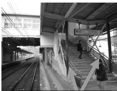
鉄骨ブレースによる補強
