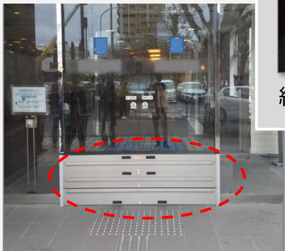
女性でも持ち運び、取付可能な 防水板を設置
