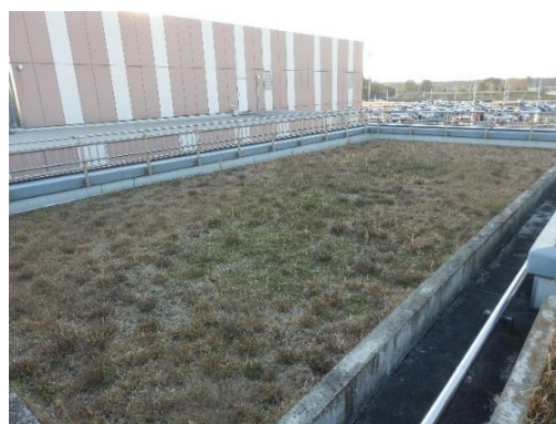
■ 屋上緑化 [空港事務所屋上]
