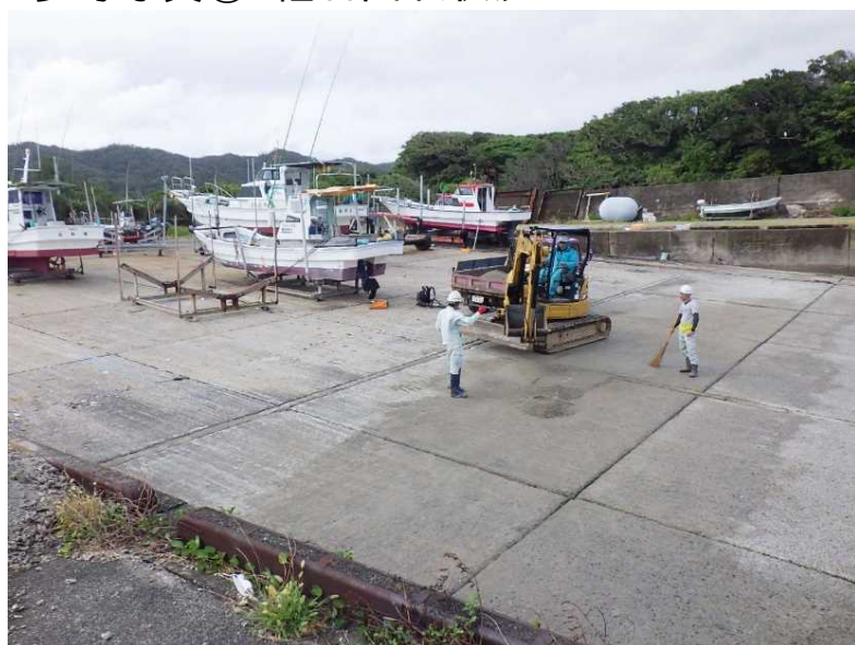
参考写真②: 軽石回収状況
