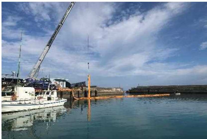
参考写真①-1: クレーンによるシルトフェンスの進水
