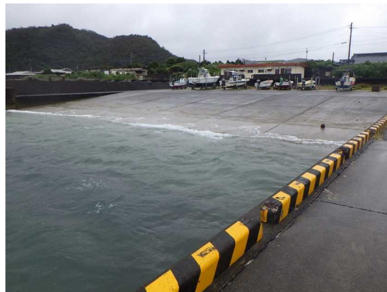
参考写真③: 作業完了
