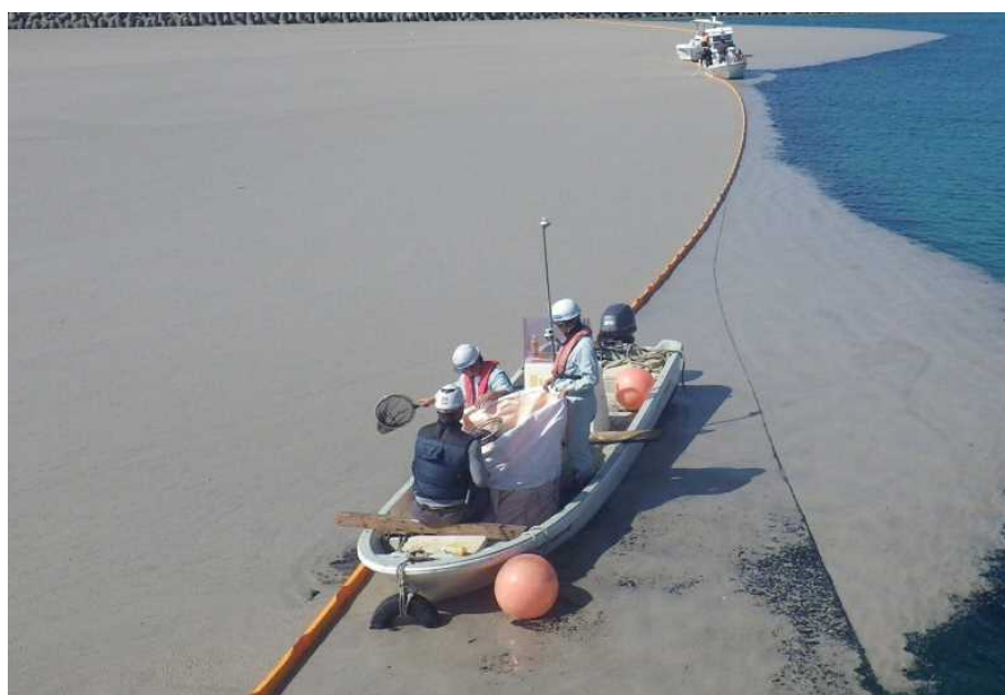
参考写真②: タモ網による人力回収状況
