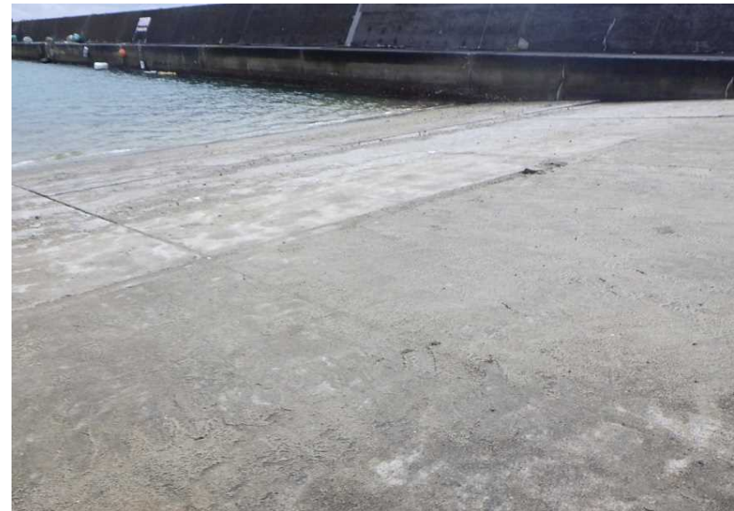
参考写真③: 作業完了
