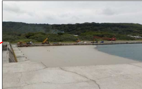
除去作業前(R3.10.19)
