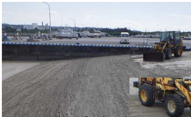
参考写真②: 船揚場(陸上部)の回収状況
