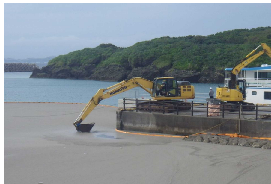
参考写真③: バックホウによる回収状況
