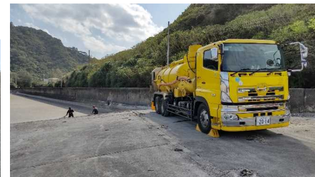
資機材配置状況
