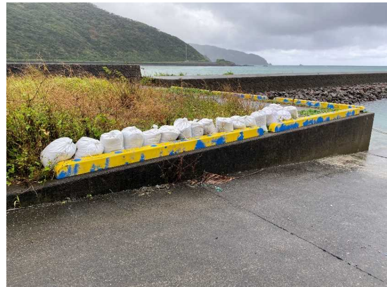
参考写真③: 回収後の仮置状況
