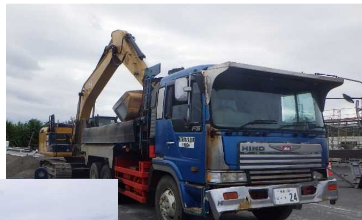
ダンプトラックへ積み込み
