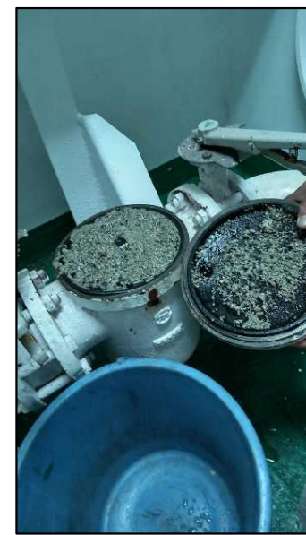
参考写真④：ストレーナーへの軽石付着状況
