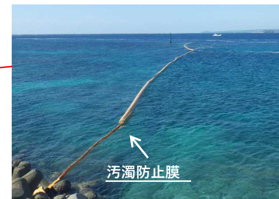
汚濁防止膜設置状況(港口側)
