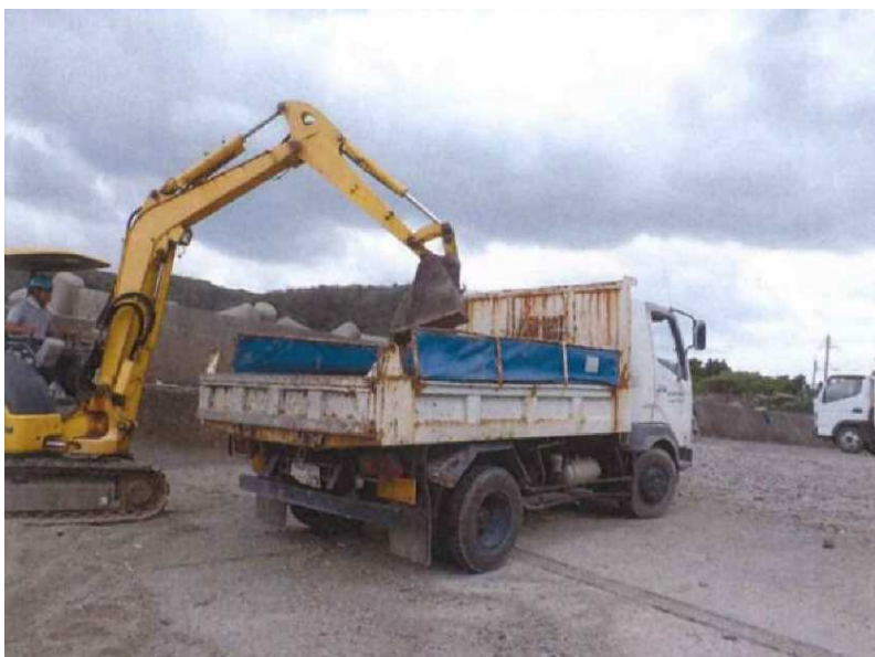
参考写真②: 軽石回収状況
