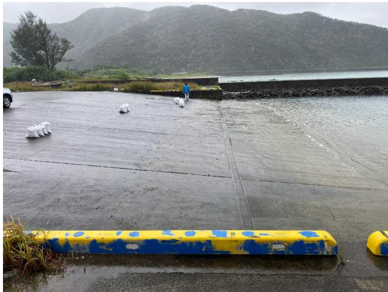
参考写真②: 作業経過
