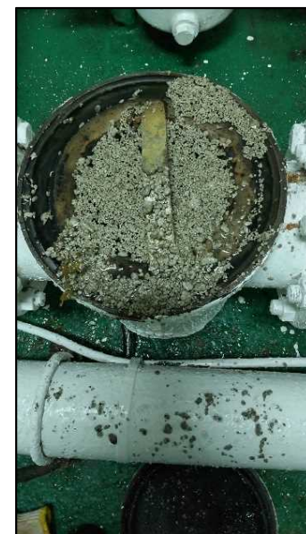
参考写真④：ストレーナーへの軽石付着状況
