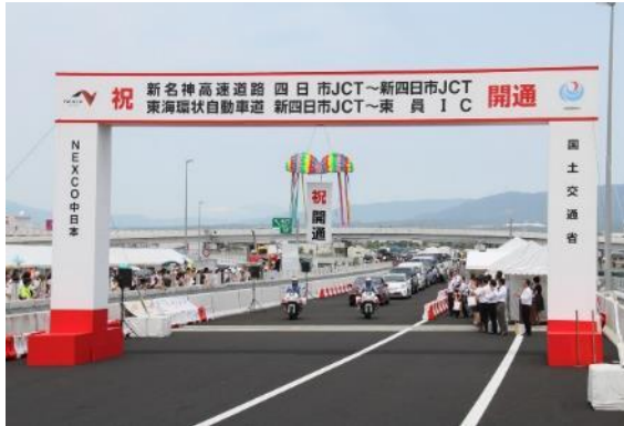
提供: 国土交通省中部地方整備局
