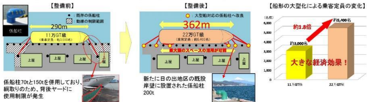
提供：国土交通省中部地方整備局
