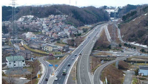
4 車線化後の東長江付近の状況
