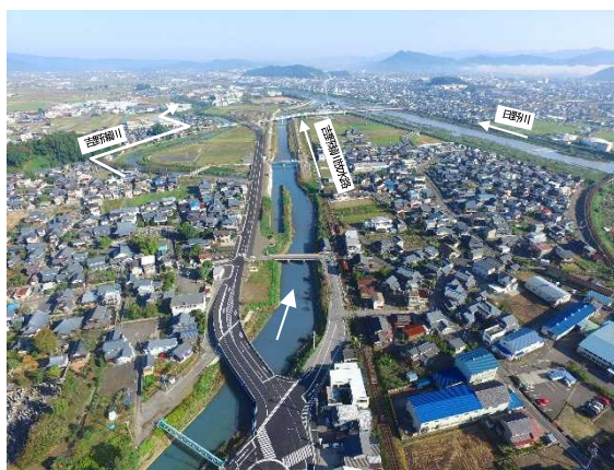
放水路の状況
