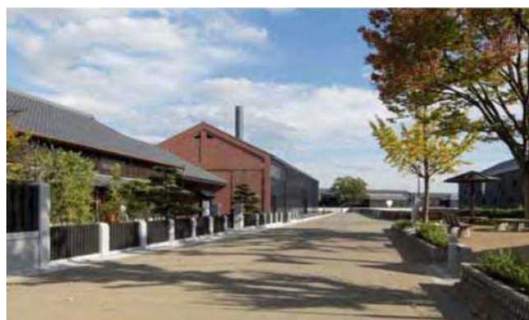
整備された道路舗装、街園
