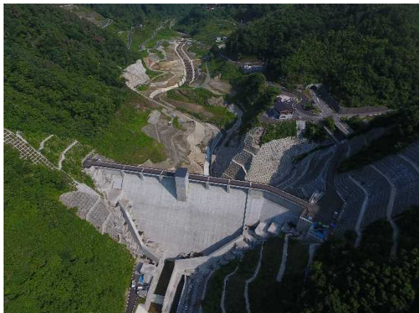
浅川ダムの空中写真
