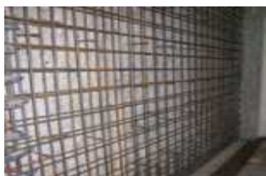
耐震壁増し打ち
