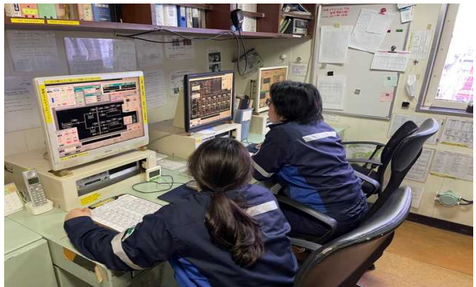
5隻のうち4隻の荷役は自動化システム導入。荷役やバラストなど、甲板上のバルブ作業の多くは荷役制御室のパソコンにより、遠隔自動制御が行われます。力仕事が減った分、オペレーションや書類仕事の割合が増え、より対等に女性の活躍の場が増えました。
