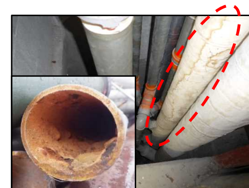
配管の腐食
