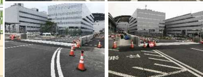
T1(南北)止水板の設置(6/26完了)
