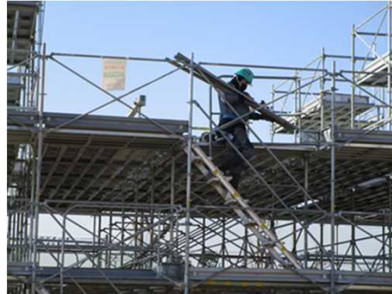
現場内小運搬（仮設足場）
