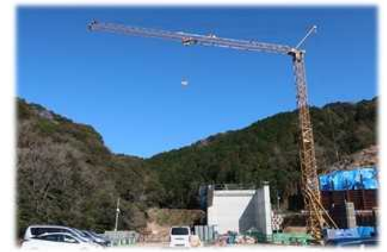
定置式水平ジブクレーン
