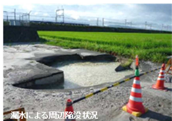
水道施設(鋼管φ400) 施設名：福岡導水排泥工 発生日：平成22年8月15日 通水停止期間：調整池の活用により通水停止なし
