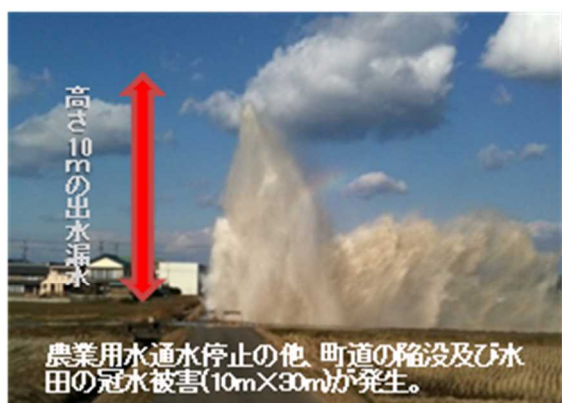
農業水利施設 (PC管φ1000) 施設名：木曾川右岸施設坂祝支線水路 発生日：平成22年2月20日 通水停止期間：2月20日～3月8日(16日間)
