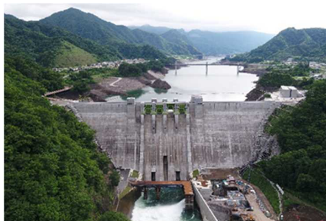
写真 3-2 ハッ場ダム(利根川水系)
