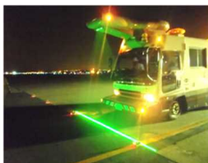
(基本施設点検実施状況)
