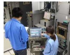
(航空保安施設点検実施状況)
