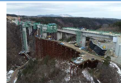
三陸沿岸道路 田野畑南～尾肝要 新思惟大橋 （令和3年1月時点）
