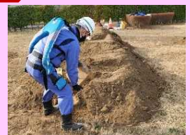
パワーアシストスーツを活用したガレキ撤去の例
