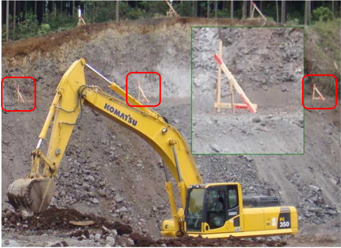
丁張りを目安に掘削位置をオペレータが判断し建設機械を操作
