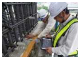
タブレット活用による検査
