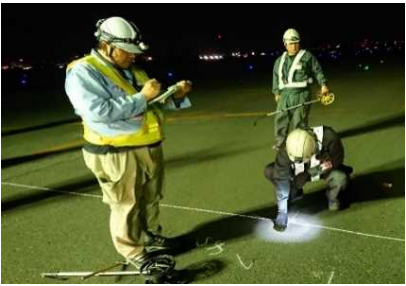
<ひび割れ計測>
